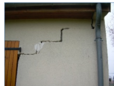
Illustrations de fissures sur un mur
