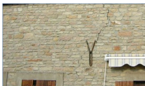
Illustrations de fissures sur un mur
